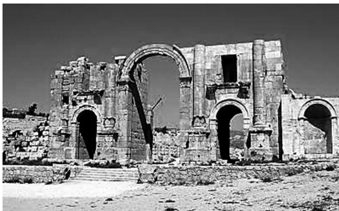
Fig. 10 Estado de ruína do arco de Adriano em Gerasa anterior ao restauro de 1980 77 .
