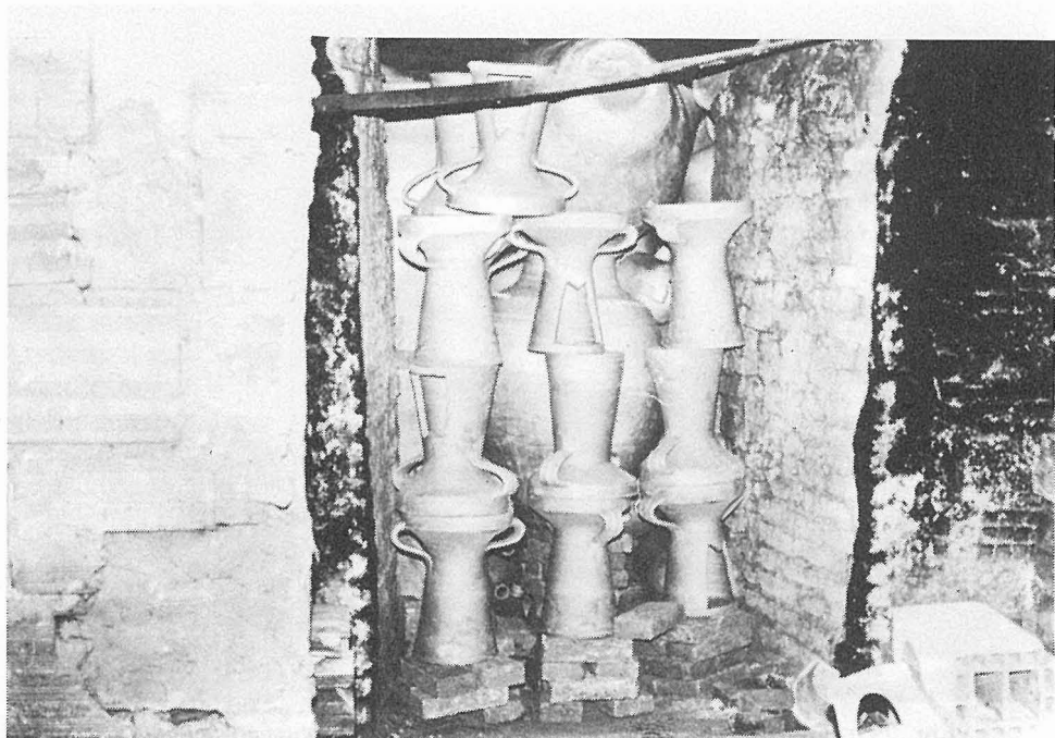
Fig. 27 — Louça de barro enfnada na caldeira , para ser cozida
