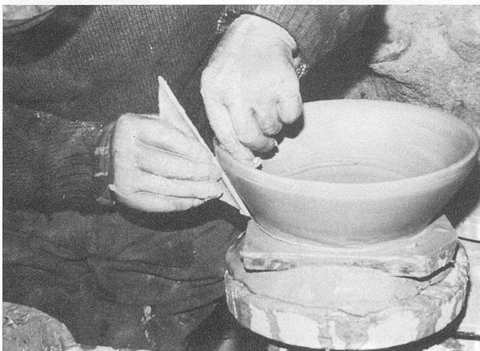
Fig. 15 — O alisar o barro, utilizando a cana
