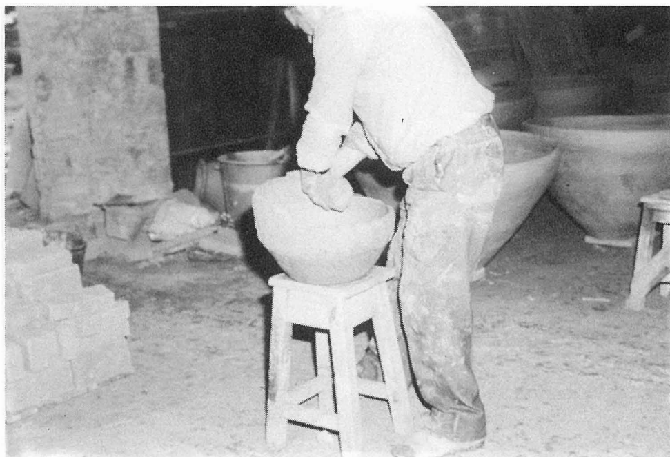
Fig. 19 — Técnica de modelagem do barro à mão, dos rolos-em-anéis ou dos rolos-em-espiral
