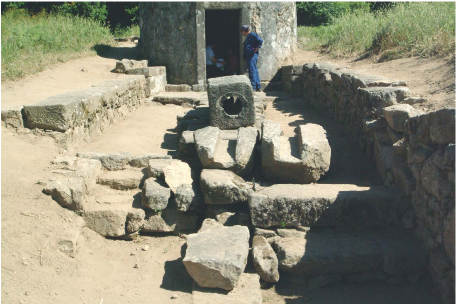
Figura 22. Fotografia de uma das torres de água (“Mãe de Água”) das Sete Fontes. Ao centro, pedra de “sifão” daquele complexo.
