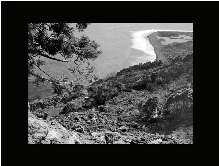
Fot. 26 – Estrada de acesso à Fajã dos Cúberes. Pormenor da disposição e das dimensões dos blocos sustidos pelo primeiro troço de estrada que atingiram. Alguns passaram ao lado e provavelmente por cima, atingindo o troço inferior da mesma estrada
