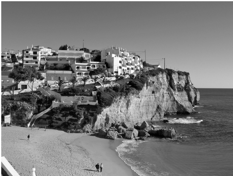
Fot. 41 – Praia do Carvoeiro, Algarve. Montão de blocos visível alguns dias depois do grande desabamento de Fevereiro de 1990
