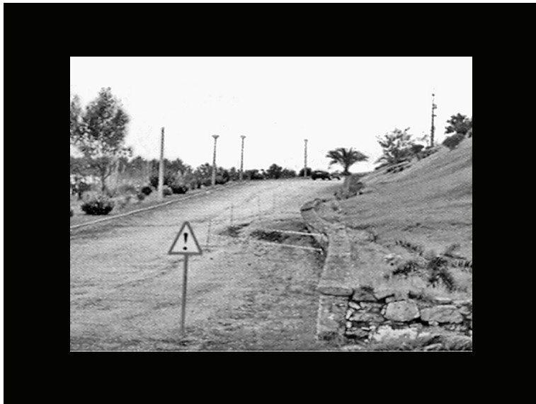
Fot. 18 – Coimbra, Dezembro de 2000 – Início de deslizamento rotacional na vertente da margem esquerda do Rio Mondego, em Santa Clara, frente a Coimbra. Em primeiro plano, «falha panamiana» criando um desnível de cerca de um metro e afectando um parque de estacionamento
